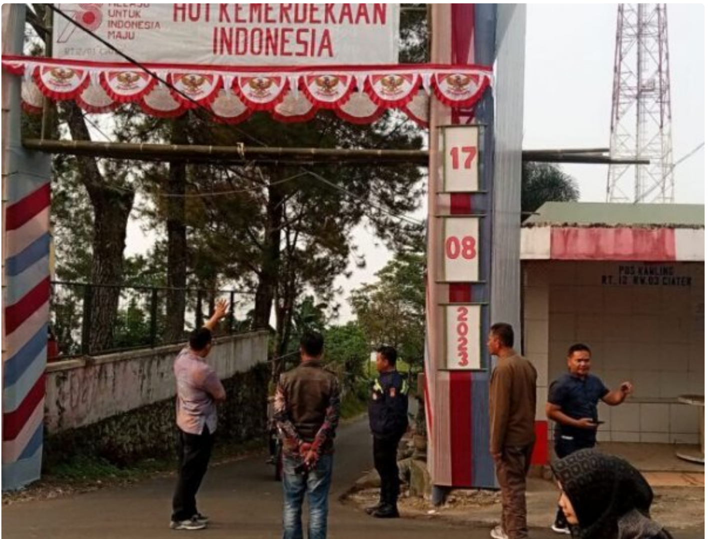
Gapura Megah Akan Dibangun sebagai Penanda Kampung Bebas Narkoba di Desa Ciater, Subang
